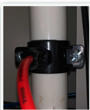
Abwasser-Anschluss-Schelle (Einbaubeispiel)
