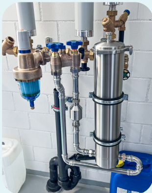
Luftmontage an Rohrschellen und einem Y-Flansch.
