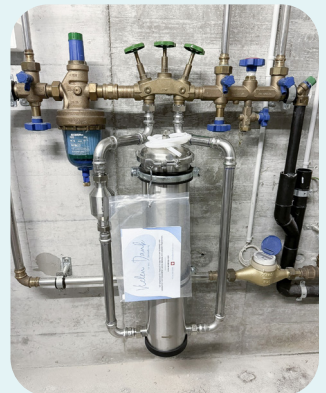
Kompakte Luftmontage an Rohrschellen.
