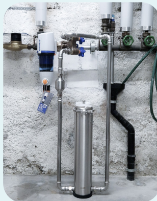
Bodenmontage an einem kompakten Y-Flansch.
