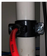
Abwasser-Anschluss-Schelle (Einbaubeispiel)
